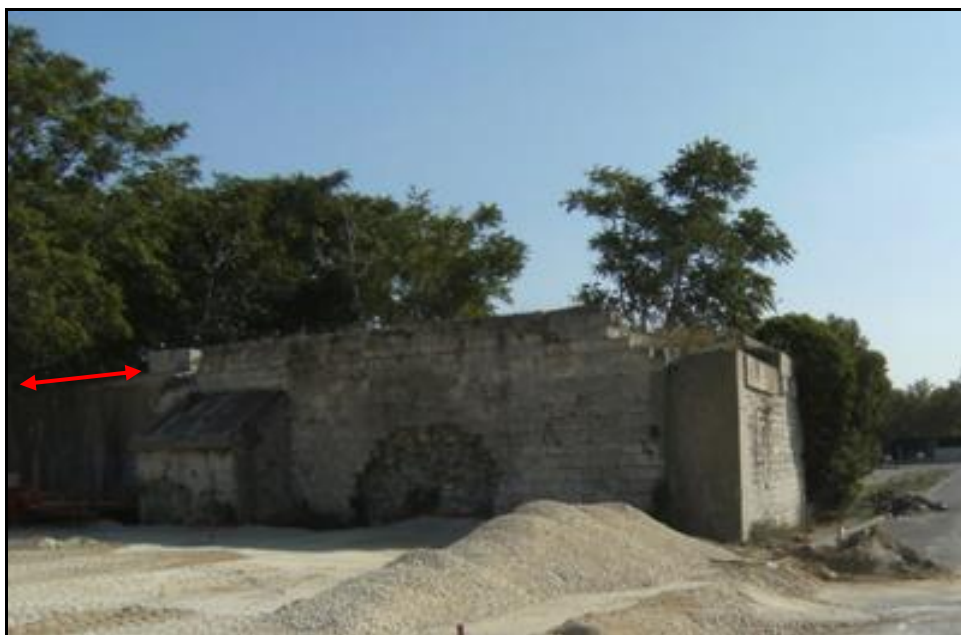
Côté nord, il laisse toujours voir la trace du pont muré de la gare de marchandises (flèche)
