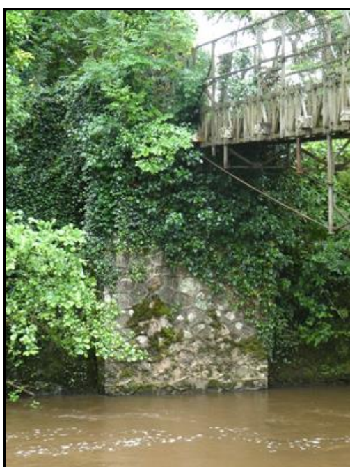
Ci-dessus et ci-dessous, la première et la dernière culées, et la pile centrale
