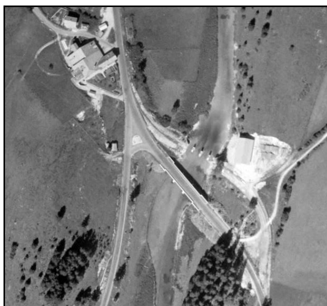
Les deux ponts du Doubs : en haut le pont temporaire dont on voit les piles Et en dessous, le nouveau pont routier exclusivement prévu pour la route et qui n'a jamais été mixte
