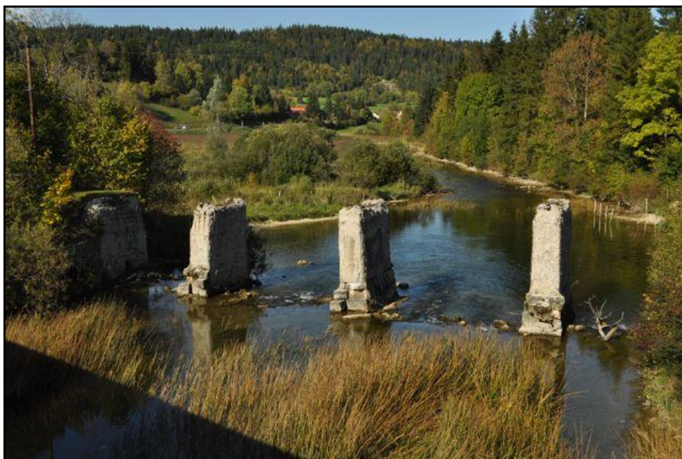
Ci-dessus et ci-dessous, les piles en béton du pont temporaire vues depuis le nouveau pont routier
