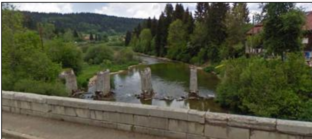
Ci-dessus et ci-dessous, les piles en béton du pont temporaire vues depuis le nouveau pont routier
