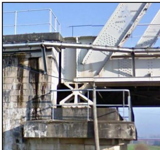
Détail d'une des culées et de l'ancrage du tablier
