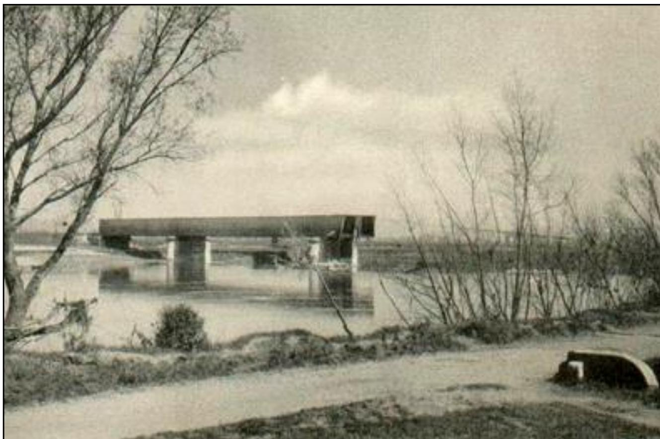
Photo montrant le pont partiellement emporté et sa section en forme de double poutre creuse
