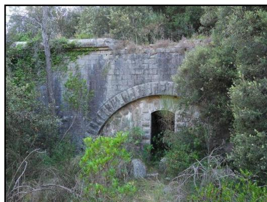
Les piles métalliques reposaient sur des massifs en maçonnerie creux
