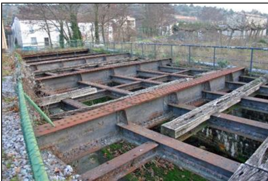
Ancien pont métallique de classe M dont la plateforme ferroviaire a disparu
