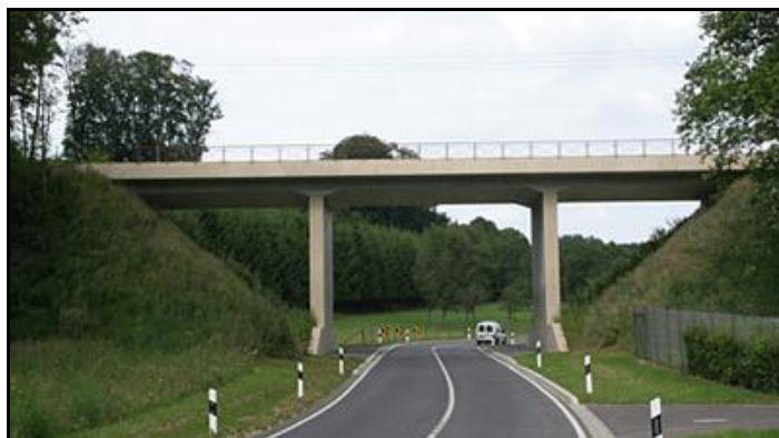
Pont béton à travées droites
