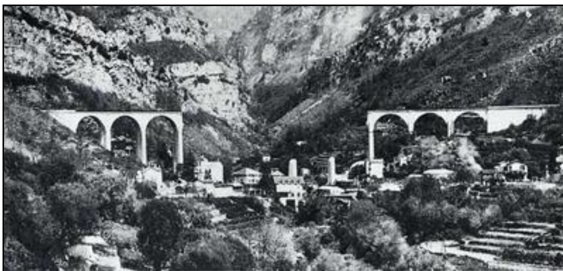
Exemple de viaduc dynamité et jamais reconstruit
