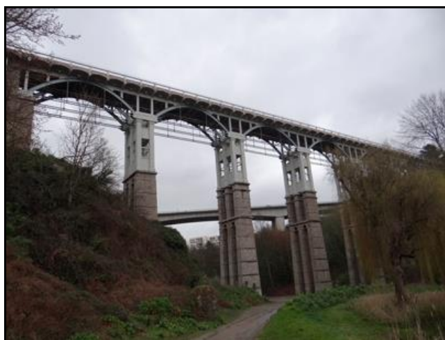
Deux viaducs en béton réalisés par Louis Harel de la Noë, mélanges d'architecture traditionnelle et d'ouvrages en arc
