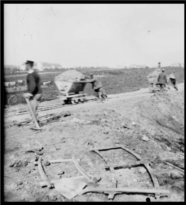
Il existe également des travées courbes de différents rayons, de 100 m pour le plus large, à 7,60 m, pour les trajets à l'intérieur des fortifications, ce qui permet à la voie de 0,60 d'adopter des parcours très sinueux. Les mêmes éléments existent également à l'écartement de 0,50 m avec des longueurs et des poids différents.
