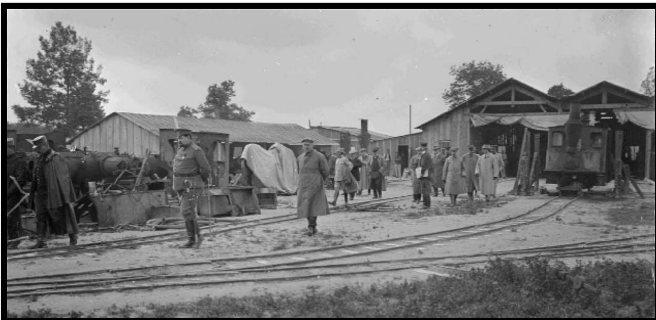
Réf. SPA 23 V 794 - Près de Suippes (Marne). Une mission parlementaire russe visite l'atelier de réparation du matériel des voies de 0,60 m. À gauche, on aperçoit la chaudière démontée d'une locomotive Péchot-Bourdon, couchée sur le flanc, dôme central visible.
