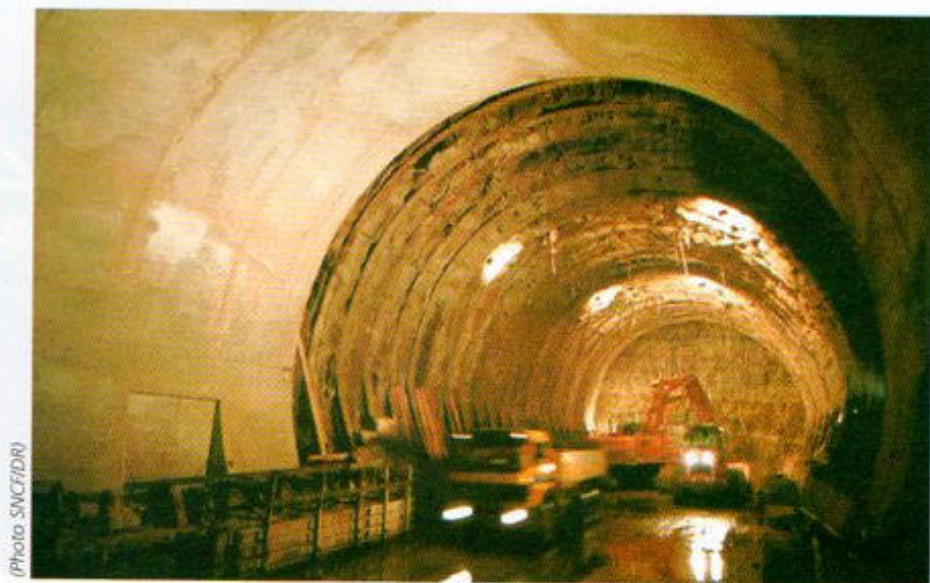
Fig. 18 - Soutènement actif ADECO-RS, Tunnel de Tartaiguille
