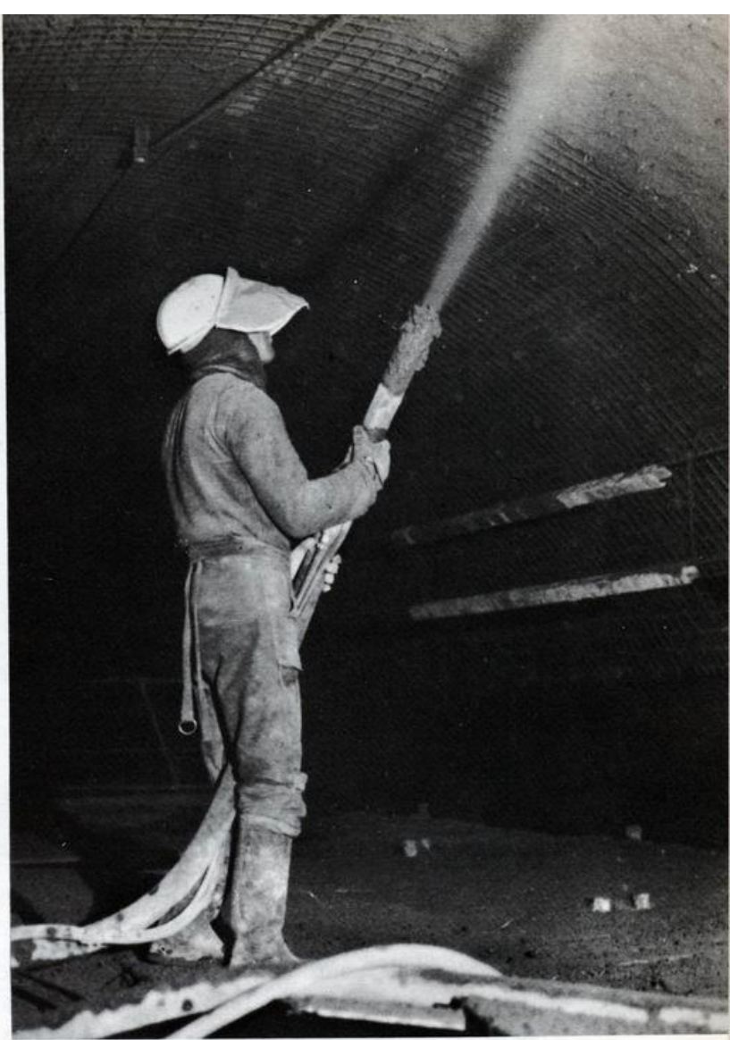
Fig. 2. — Tunnel de Belleville : projection de béton par voie sèche avec prémouillage.
