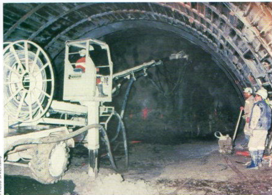
Fig. 16 - Soutènement lourd, Tunnel de Marseille
