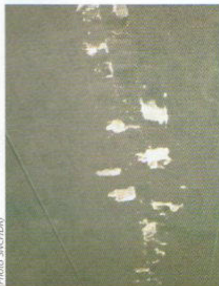
Fig. 11 - Défaut de clavage, Tunnel de Chalezeule
