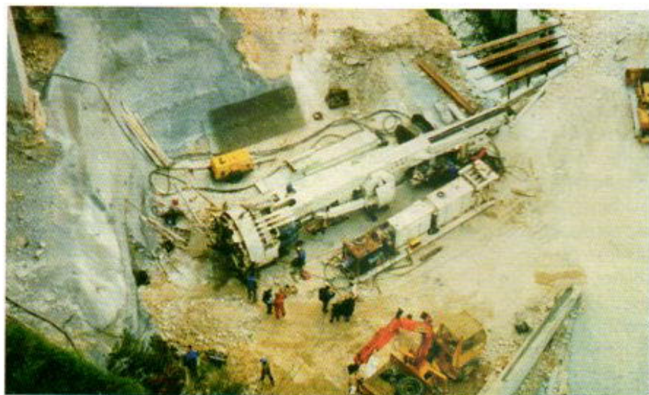
Fig. 19 - Tunnelier TBM Robbins, Galerie de Monaco
