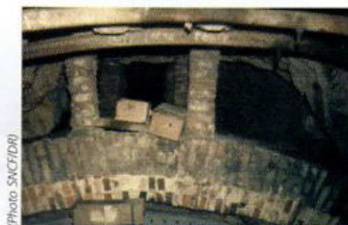
Fig. 14 - Renforcement par piliers, Tunnel de Corbinères
