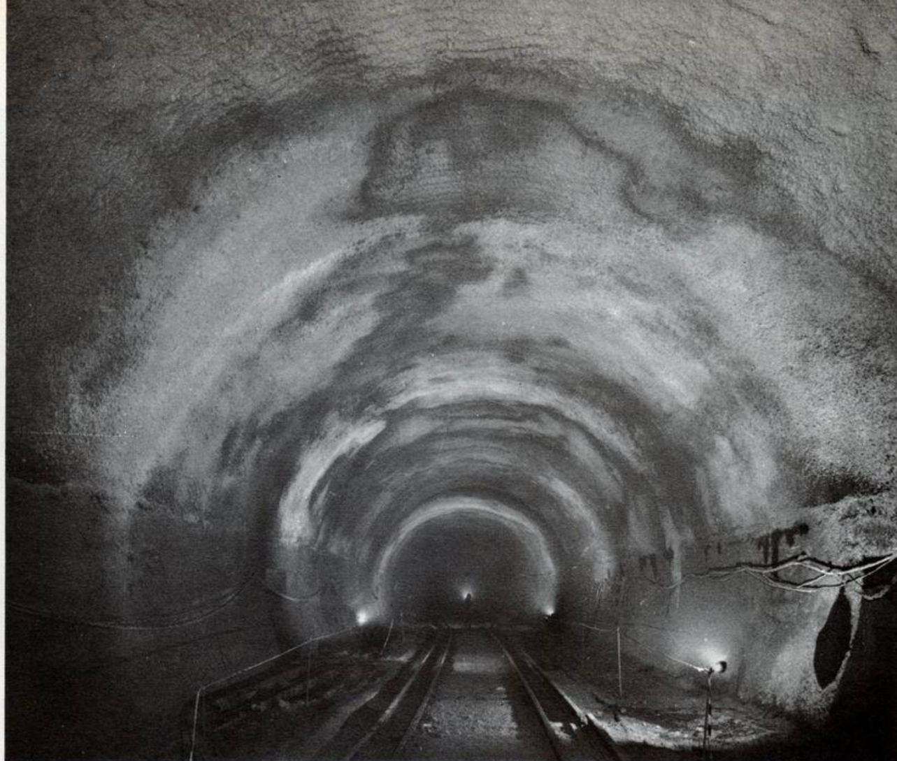
Fig. 19. — Tunnel de Belleville : remise en état des voûtes sous pose préalable de cintres.
