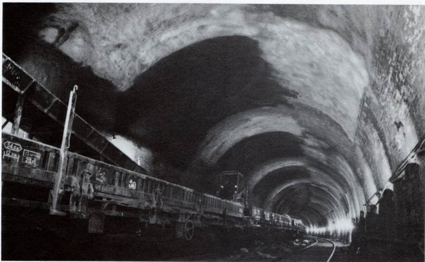
Fig. 21. — Tunnel de Perternère : achèvement de la nouvelle voûte en béton projeté.
