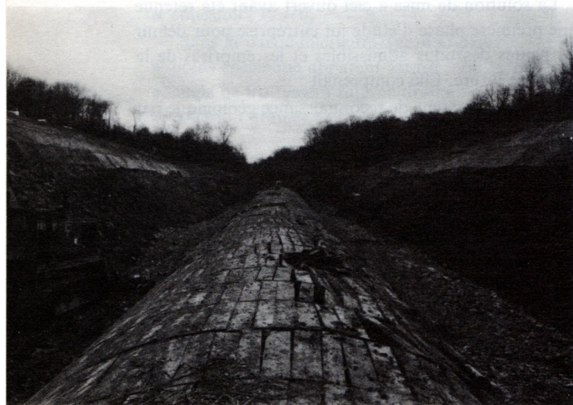
Fig. 9. — Tunnel de Grattery. Couchis après démolition de la voûte.
