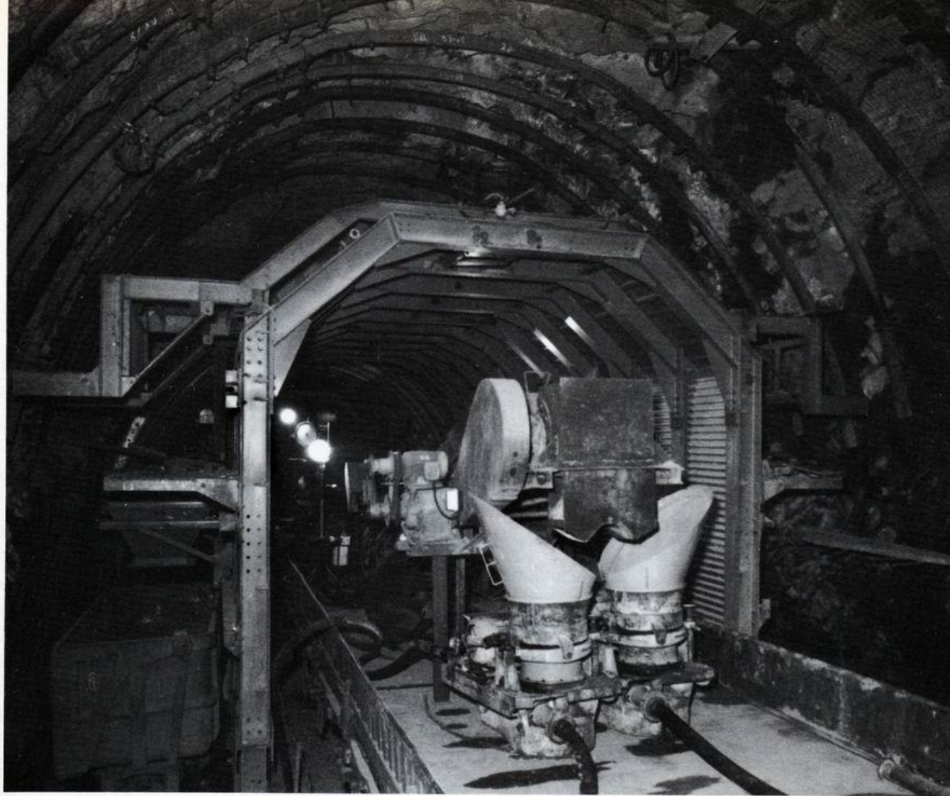
Fig. 12. — Tunnel des Corbinières : pose des cintres métalliques Launay.
