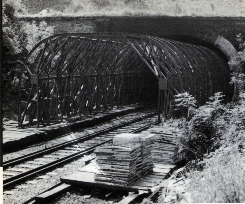
Fig. 1. — Tunnel d'Hardelot. Assemblage des cintres à la tête Nord.
