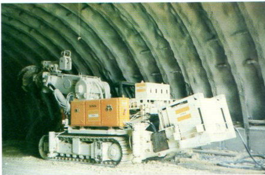
Fig. 15 - Machine à attaque ponctuelle PAURAT, Tunnel de Vouvray
