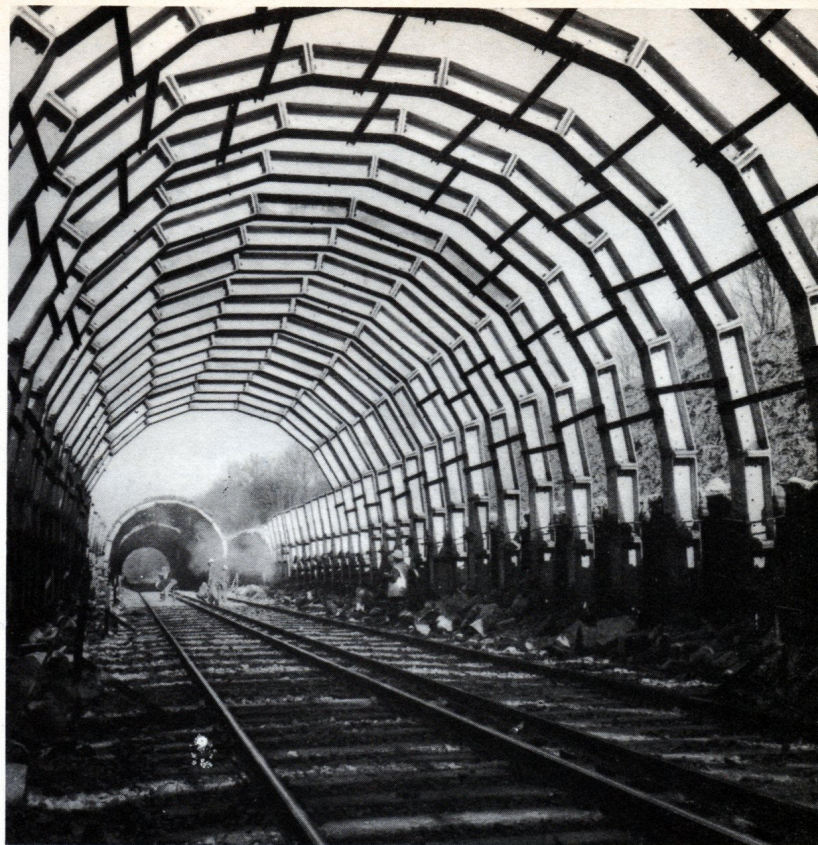
Fig. 10. — Tunnel de Grattery. Cintres lourds après démolition du tunnel.
