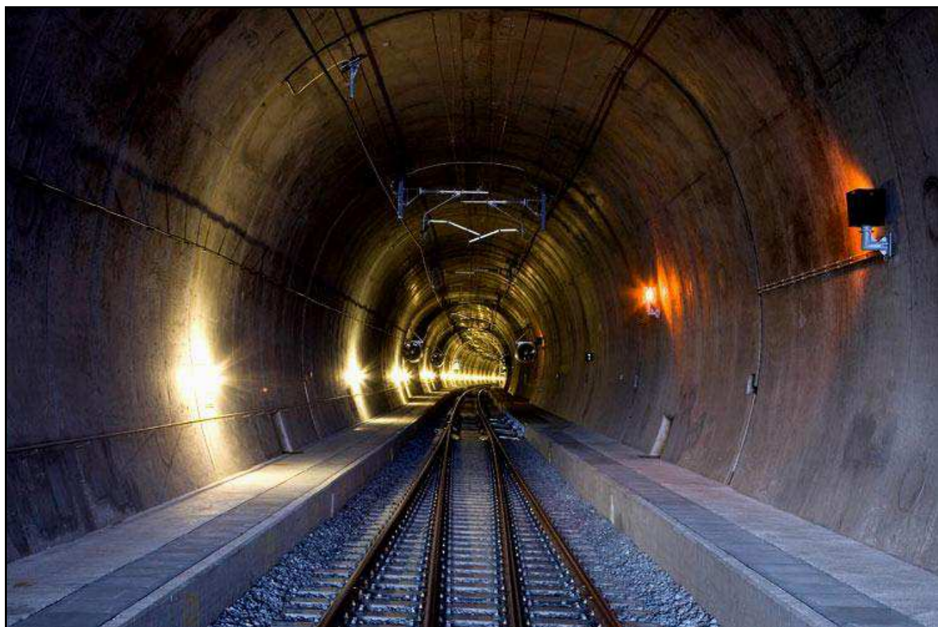
Galerie de circulation d'un nouveau tunnel de base Notez les trottoirs d'évacuation.
