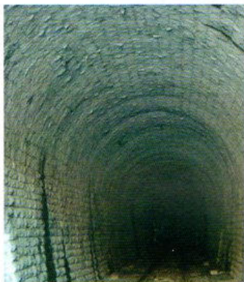
Fig. 10 - Ondulations répétitives de la maçonnerie, Tunnel du Peilhou
