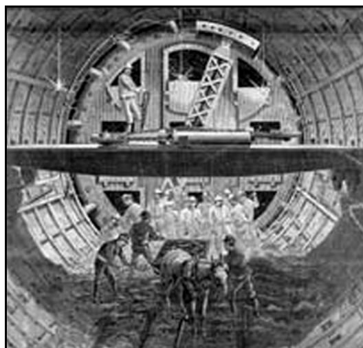
Ci-dessus et ci-dessous, travail sous bouclier de protection
