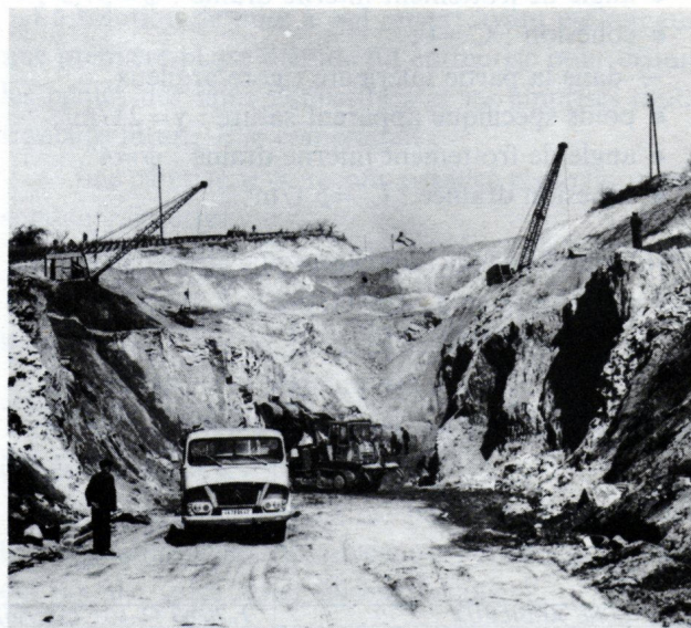
Fig. 4. — Tunnel du Crozet. Dégagement de la tête côté Roanne.
