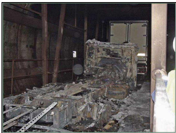
Ci-dessus et ci-dessous, les dégâts sur une locomotive, les camions, les wagons et la voûte
