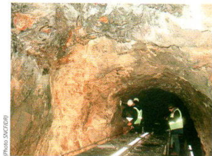
Fig. 26 - Inspection d'un tronçon non revêtu, Tunnel de Chazelles
