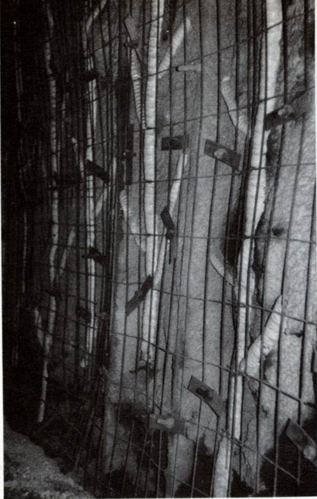
Fig. 13. — Tunnel des Corbinières : pose des gaines de drainage souples CPV type Aliva.
