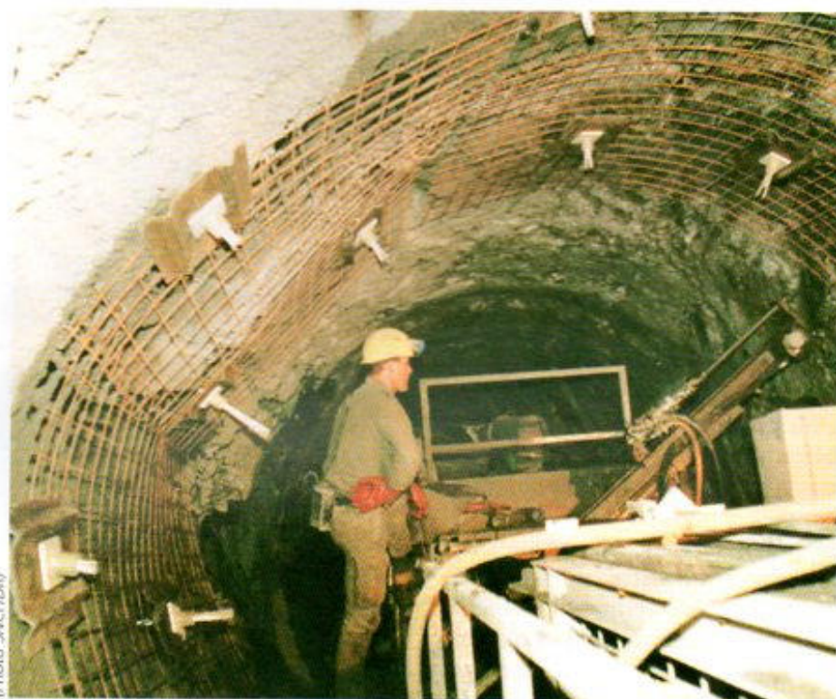
Fig. 20 - Soutènement à l'arrière du TBM, Galerie de Monaco
