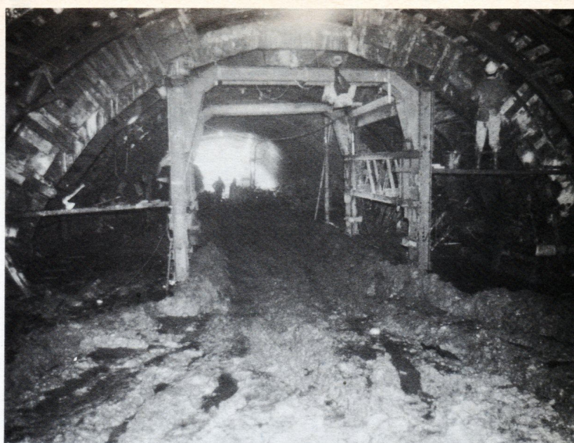
Fig. 24. — Tunnels de La Pommeraie et de Marnay. Coffrage en place lors du bétonnage de la voûte.
