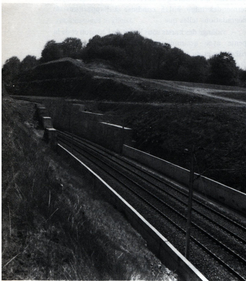
Fig. 16. — Tunnel de Colmey. Murs de pied dans les zones d'extrémité.
