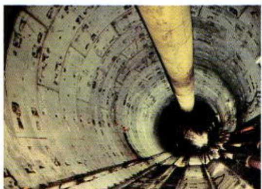
Fig. 21 - Anneaux de voussoirs, Tunnel de Villejust
