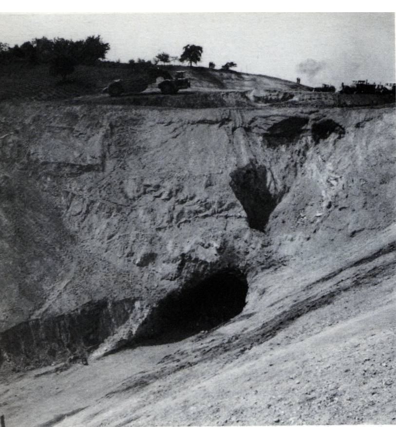
Fig. 5. — Tunnel du Crozet. Terrassement en cours et cratère n° 3.
