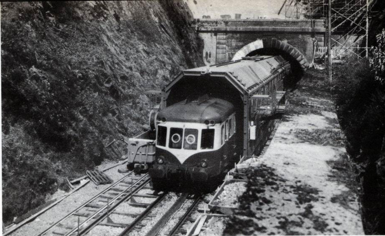
Fig. 10. — Sortie du tunnel des Corbinières : on distingue le portique, la voie de 75 cm et la clôture.
