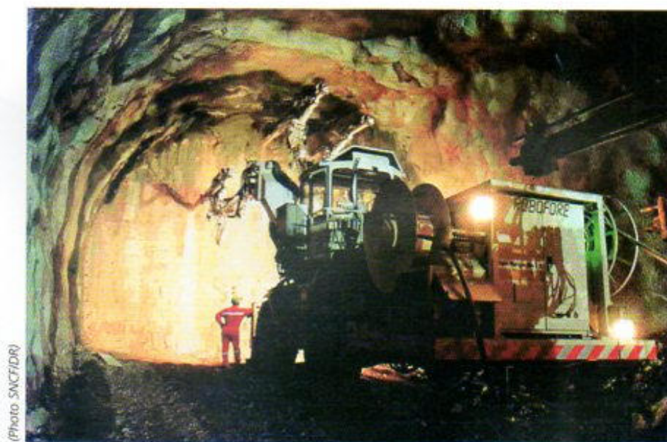
Fig. 17 - Soutènement léger NATM, Tunnel de Marseille
