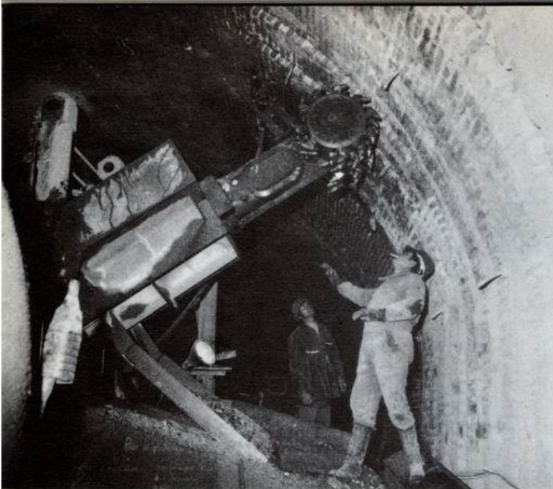
Fig. 16. — Tunnel de Saint-Elme : rescindement de la voûte à l'aide de la fraise sur bras télescopique.
