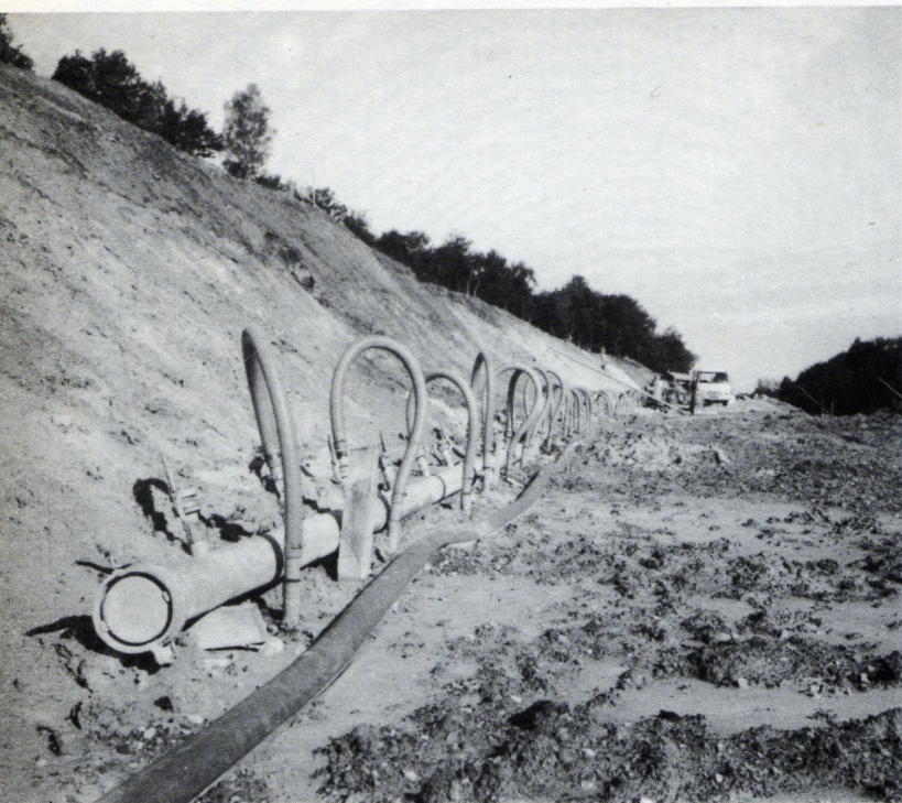
Fig. 12. — Tunnel de Grattery. Ligne de pointes filtrantes.
