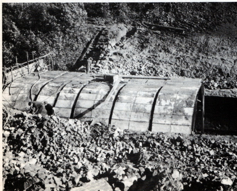
Fig. 2. — Tunnel d'Hardelot. Démolition de la voûte.
