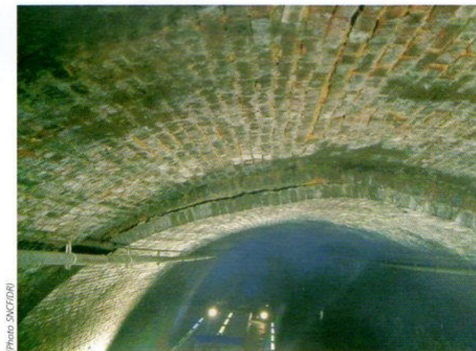
Fig. 12 - Tassement d'un rouleau de briques, Tunnel de La Motte
