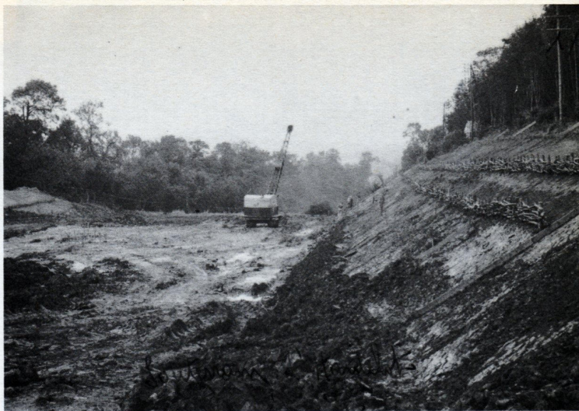
Fig. 3. — Tunnel d'Hardelot. Terrassement en cours et fascinage.
