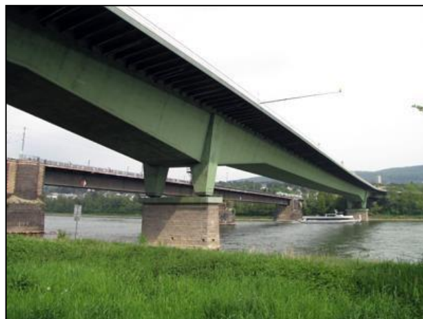
Pour accroître la portée des ponts et leur rigidité, on réalise aussi des ouvrages sur des poutres en forme de caissons creux. Elles peuvent être métalliques comme ci-dessus, ou en béton comme ci-après
