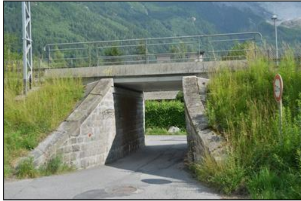
Travée en béton armé classique
