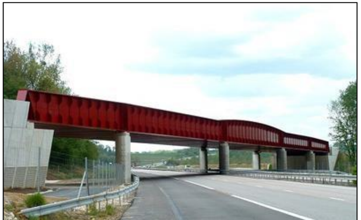
Ci-dessus et ci-dessous, ponts à poutres latérales pleines et ajourées
