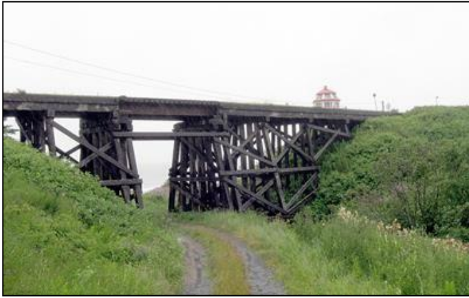
Ponts militaires en bois construits selon le principe des estacades portuaires
