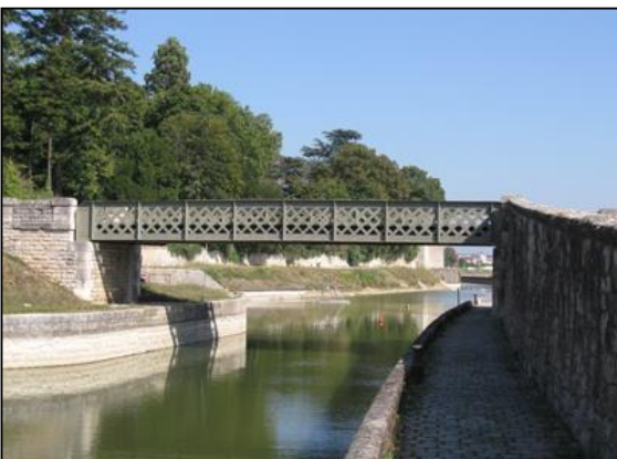
Ci-dessus et ci-dessous, ponts à poutres latérales pleines et ajourées
