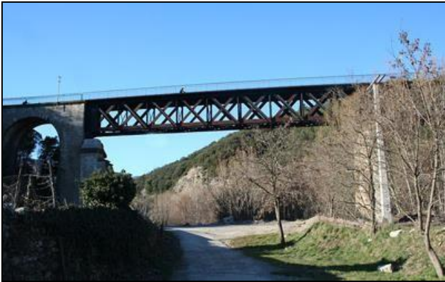
Parfois, les caissons métalliques peuvent avoir des parois ajourées en forme de treillis comme ci-dessus
