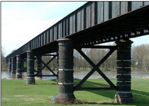
Ci-dessus et ci-dessous, ponts à poutres latérales pleines et ajourées
