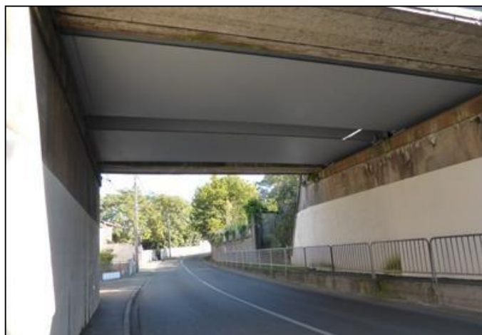
Pont avec tabliers RaPUM au centre de l'image et poutres latérales de liaison et protection
