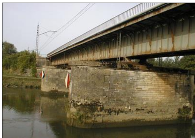
Pour accroître la portée des ponts et leur rigidité, on réalise aussi des ouvrages sur des poutres en forme de caissons creux. Elles peuvent être métalliques comme ci-dessus, ou en béton comme ci-après
