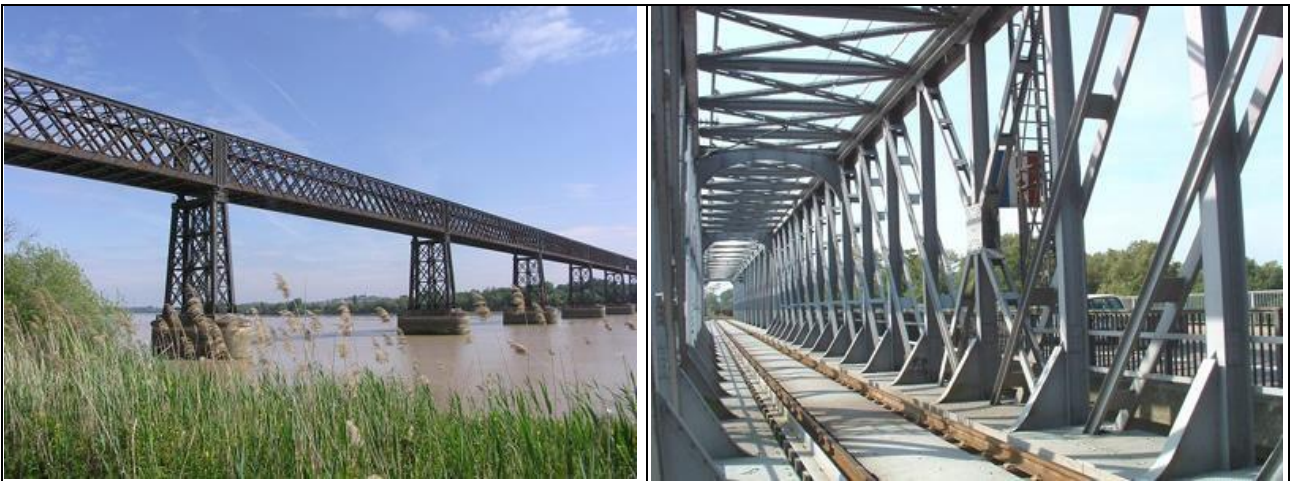
Pont treillis, ou poutre creuse ajourée
