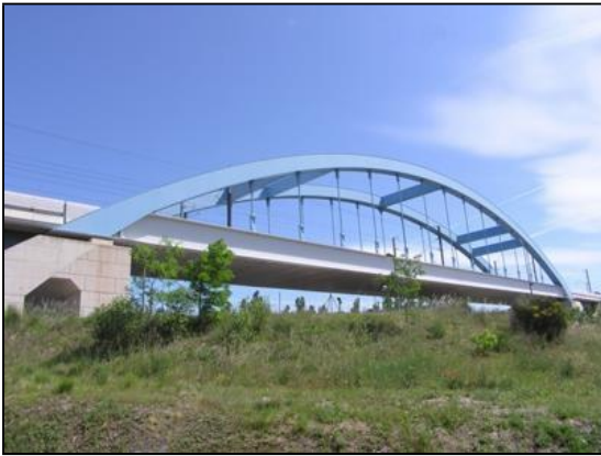
Ci-dessus et ci-dessous, les trois modèles de ponts à arc avec tabliers inférieur, médian et supérieur
