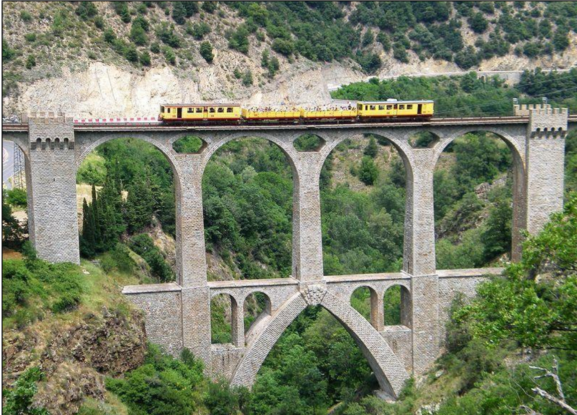
Bien que viaduc, cet ouvrage est nommé Pont Séjourné Les ouvertures secondaires (élégissements) pratiquées dans ses tympans rendent sa structure particulièrement altière et légère
