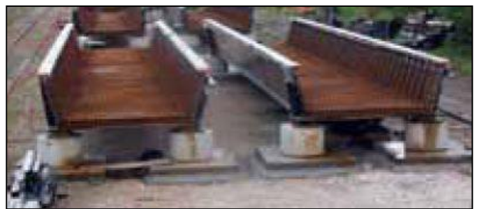
Travées RaPUM aussi surnommées "bacs à fleurs" en raison de leur forme La voie ferrée passera dans la cuvette centrale
