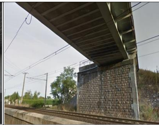
Travée mixte à poutrelle transversales
