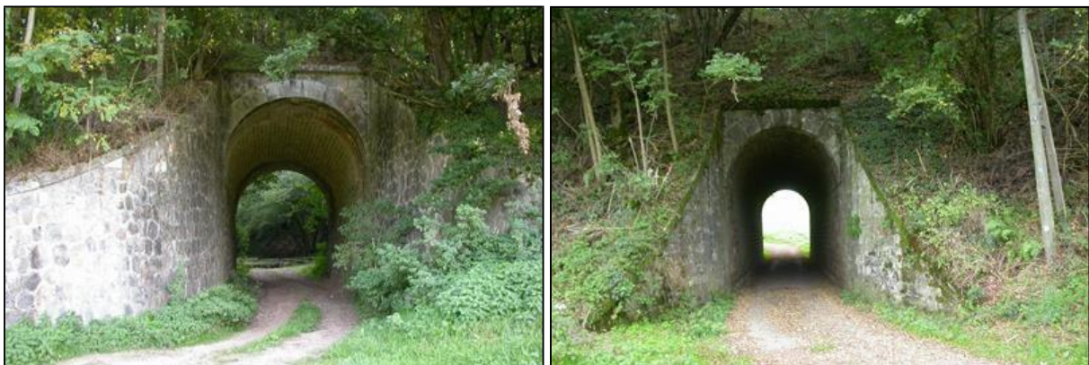
Ponceaux ponts traditionnels
