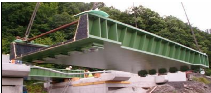
Travées RaPUM aussi surnommées "bacs à fleurs" en raison de leur forme La voie ferrée passera dans la cuvette centrale
