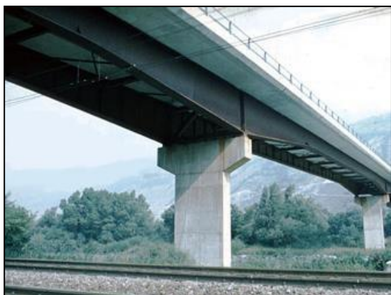
Lorsque la portée devient plus longue, les ponts reposent sur des poutres plus épaisses de section en I
