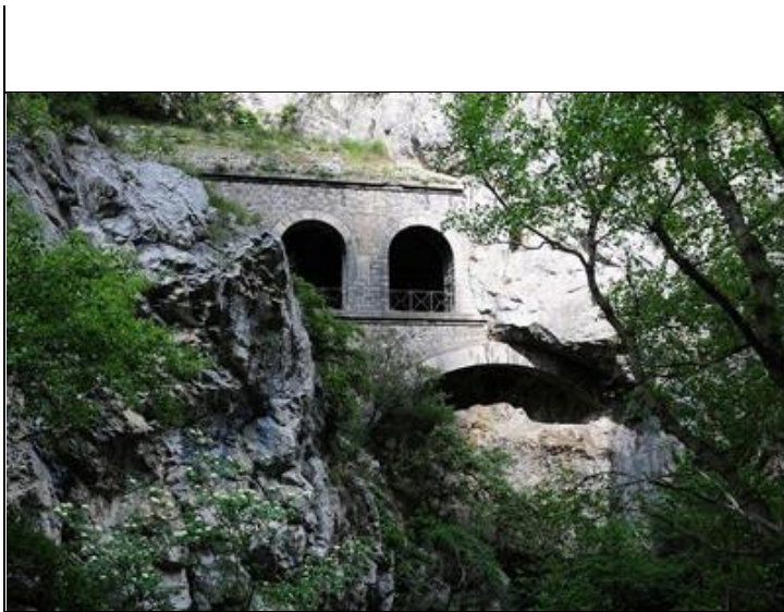
Ci-dessus et ci-dessous, pont de soutènement supportant un tunnel
