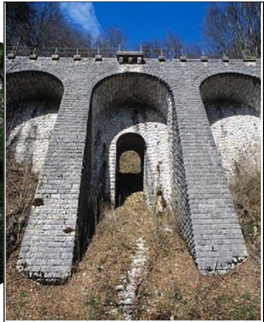
Viaduc borgne de soutènement
