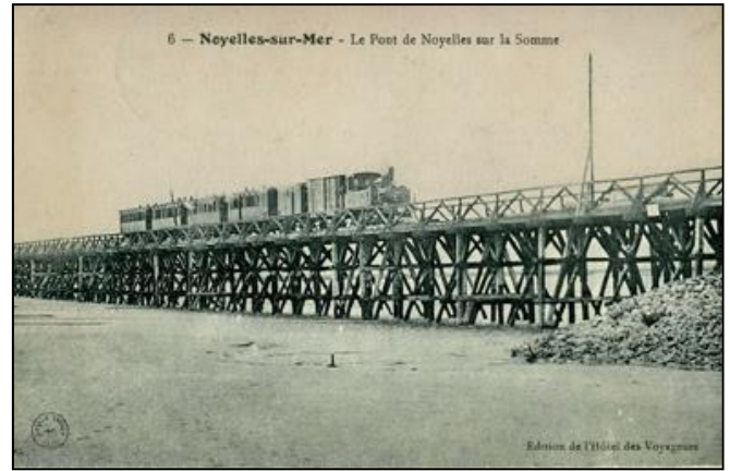
Ponts militaires en bois construits selon le principe des estacades portuaires
