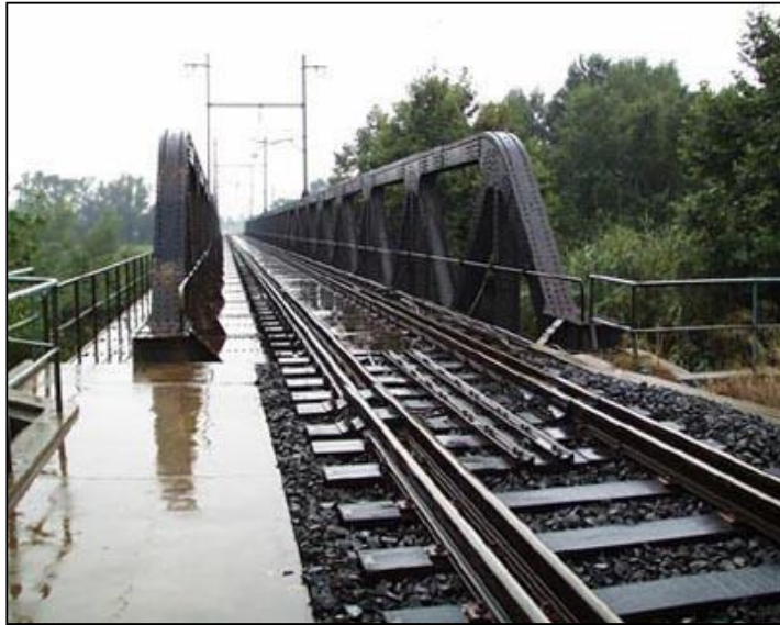
Vue d'un tablier de pont à poutres latérales (ici ajourées)
