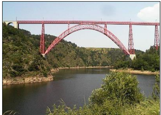
Ci-dessus et ci-dessous, les trois modèles de ponts à arc avec tabliers inférieur, médian et supérieur
