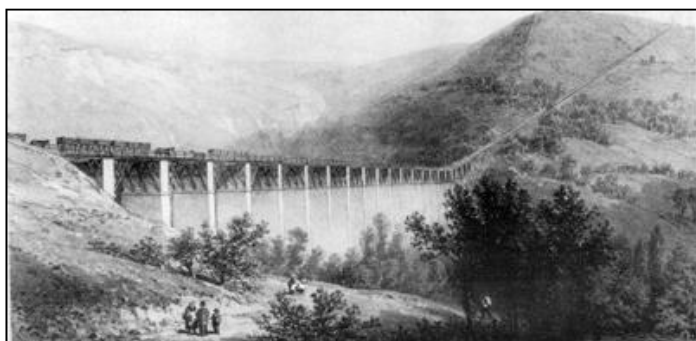
Sur une ligne minière, gravures anciennes représentant deux viaducs à tabliers en bois reposant sur des piles en maçonnerie
