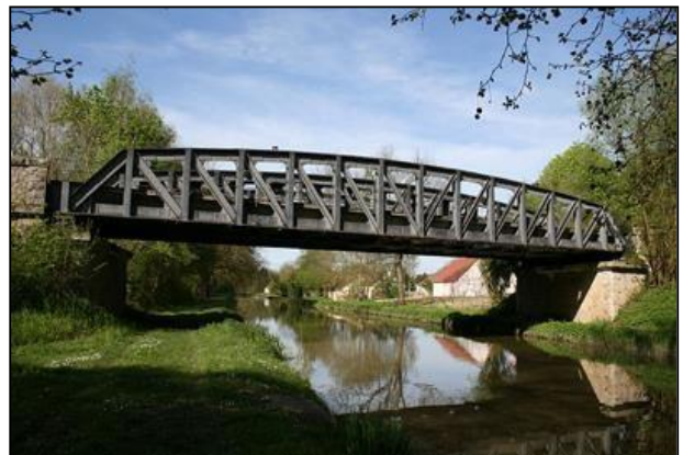
Ci-dessus et ci-dessous, ponts à poutres latérales pleines et ajourées
