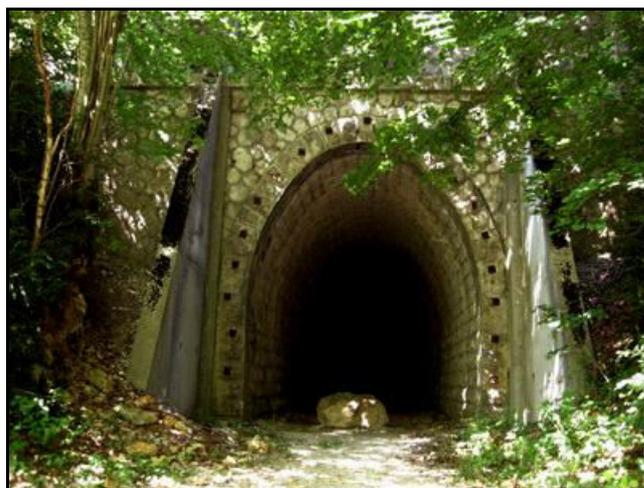
Les têtes des tirants d'ancrage et les contreforts béton sont ici bien visibles
