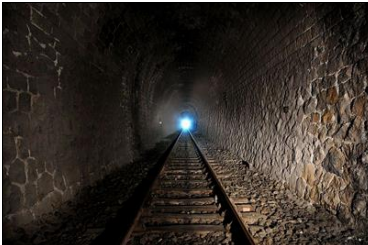
La galerie du tunnel
