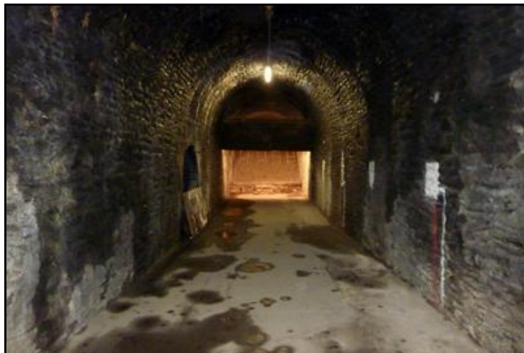
Ci-dessus et ci-dessous, la deuxième moitié du tunnel en regardant vers le fond (sortie) Sur la gauche, l'une des deux communications qui permet de descendre dans la galerie allemande
