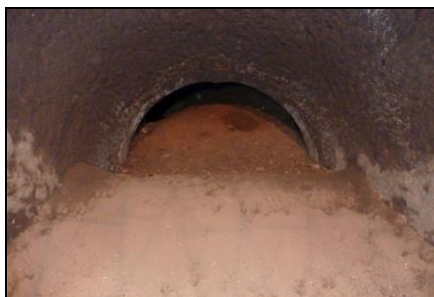
Bien visible sur la photo de droite, le tunnel initial a fait l'objet d'un prolongement creusé à un gabarit supérieur
