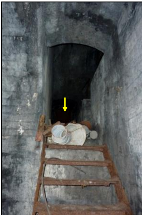
Côté entrée, accès au corps de garde depuis la galerie allemande Le tunnel est au fond (flèche jaune)
