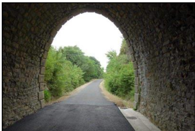
Ci-contre, l'entrée vue après travaux avec la piste de la voie verte
