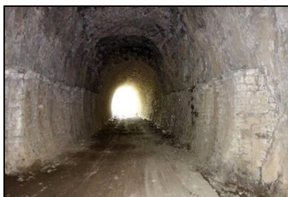
Les premiers mètres de la galerie possèdent un parement en maçonnerie, mais sont suivis par la traversée d'une veine de terrain où la voûte a été laissée en roche nue
