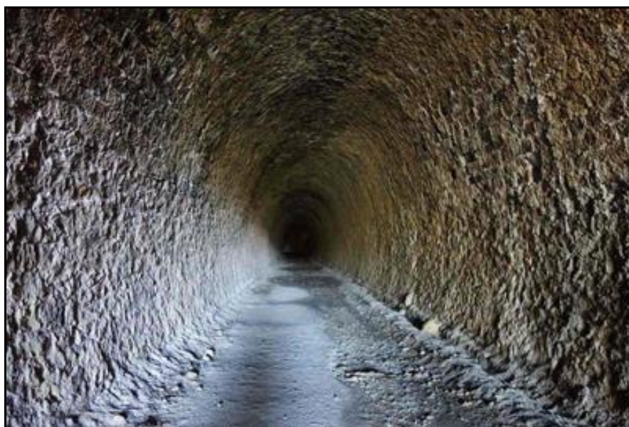
Puis le reste de la galerie est à nouveau maçonné
