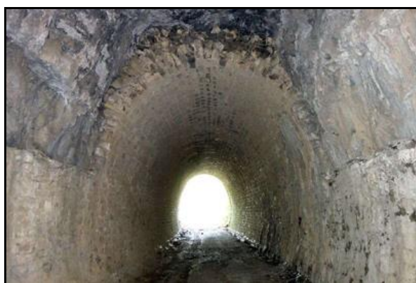
Les premiers mètres de la galerie possèdent un parement en maçonnerie, mais sont suivis par la traversée d'une veine de terrain où la voûte a été laissée en roche nue
