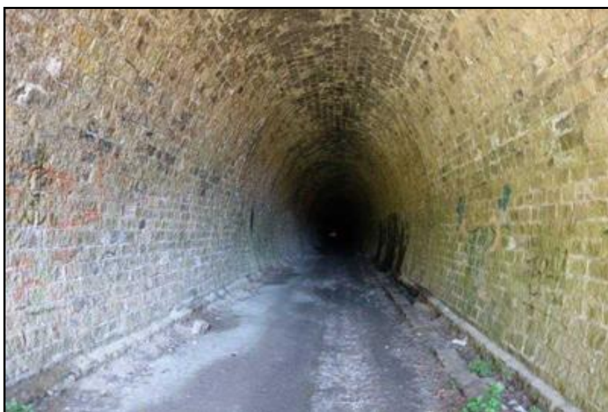
Puis le reste de la galerie est à nouveau maçonné
