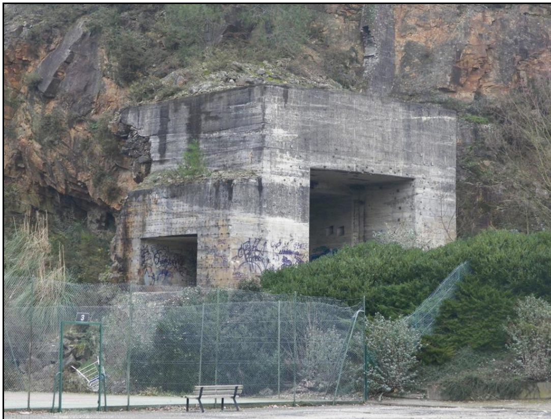
L'entrée fortifiée de l'ouvrage L'entrée ferroviaire est le grand orifice de droite
