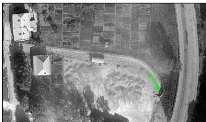
Vue aérienne de l'entrée du tunnel au niveau de l'usine
