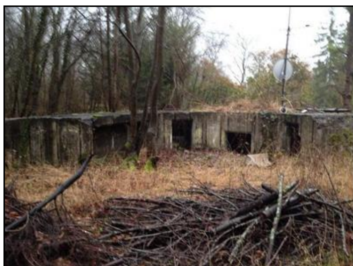
Poste de tir pour canon antiaérien chargé de protéger le site
