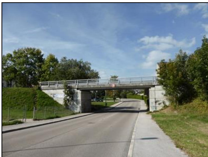
Le pont de la rue du Lycée
