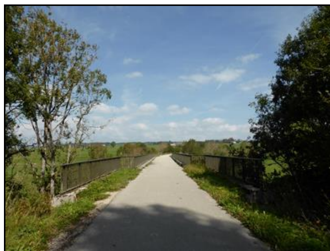
Le dessus du pont vu à contresens de la ligne
