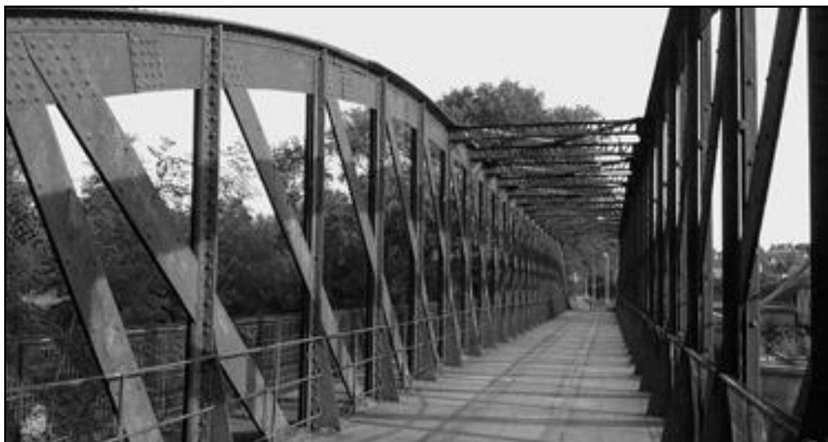
Ci-dessus et ci-après, le pont métallique du tacot métrique sur l'Indre devenu passerelle piétonnière
