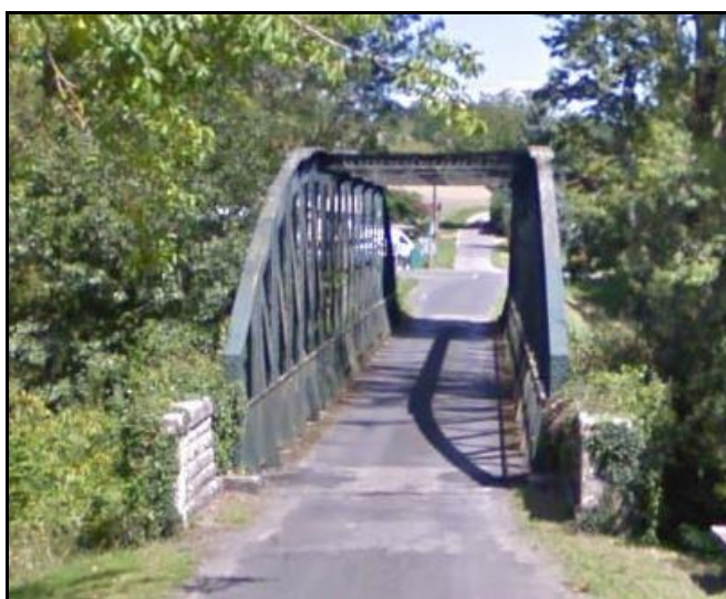
Ci-dessus et ci-après, vu à contresens de la ligne, le pont du chemin de fer départemental sur la Cloise juste avant d'arriver à la gare terminus du Grand Pressigny Il est identique à la passerelle d'Esvres, mais toujours utilisé pour des besoins routiers
