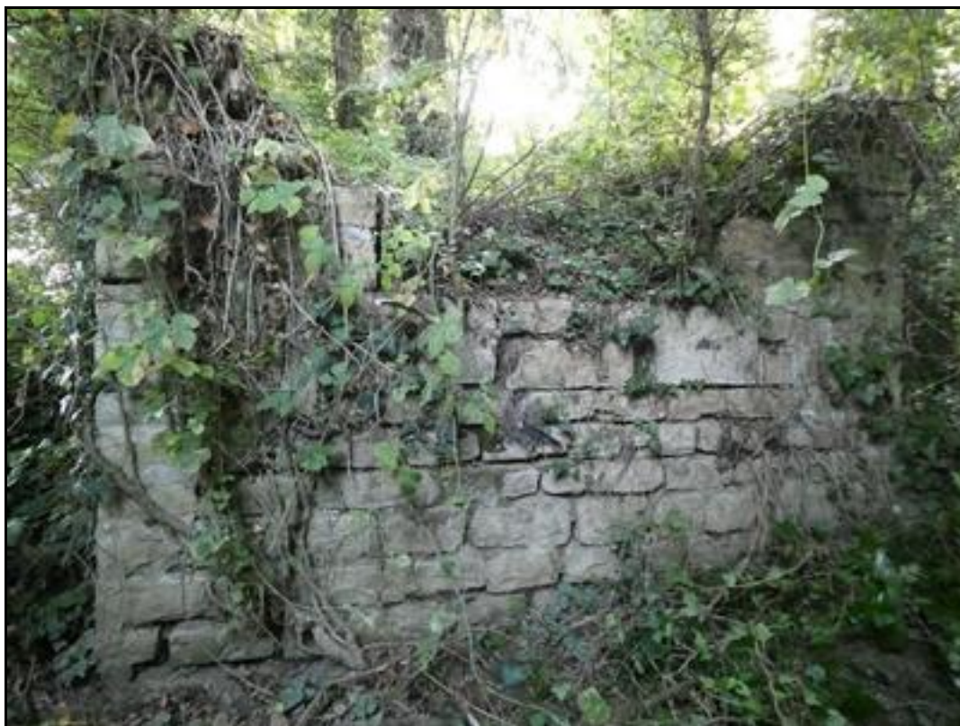
Ci-dessus et ci-dessous, l'autre culée plus abîmée
