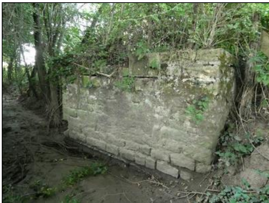
L'une des deux culées en bon état général avec ses pierres d'appui du tablier métallique
