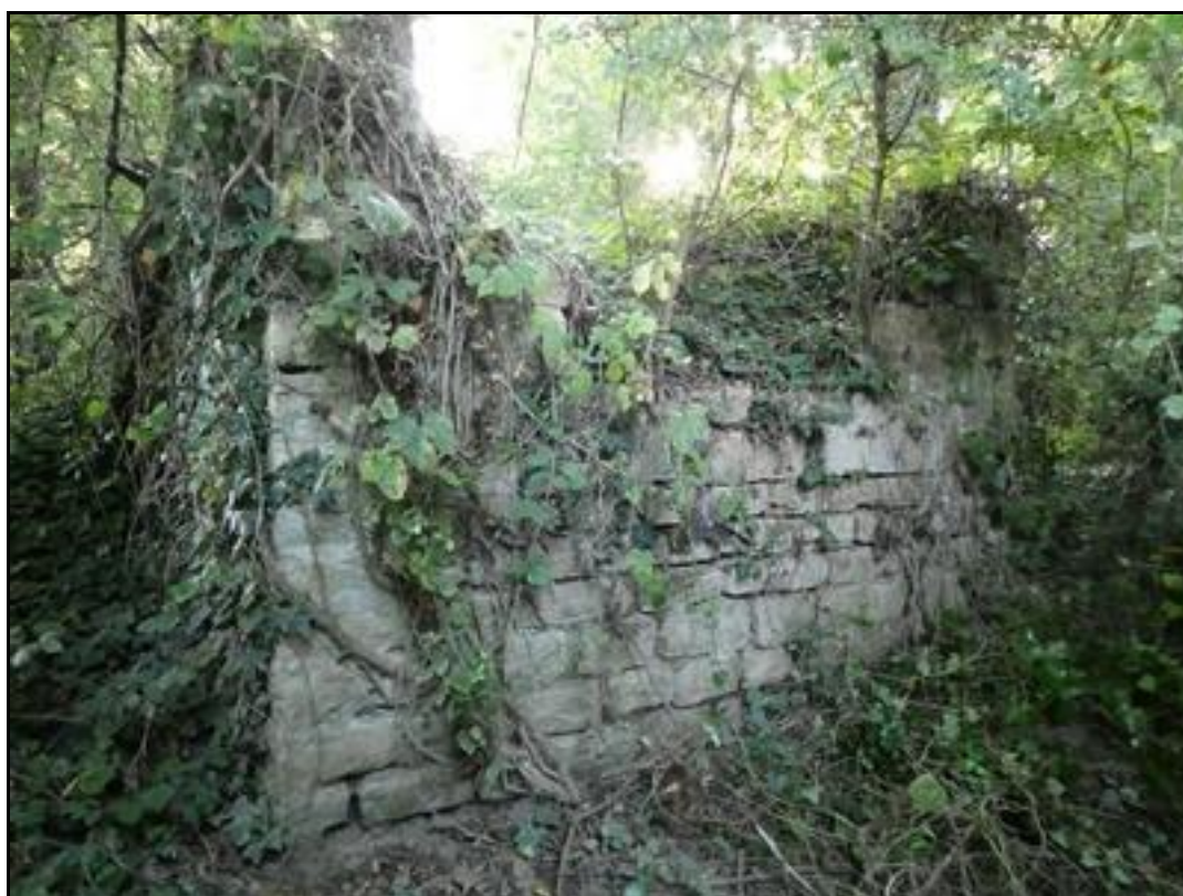
Ci-dessus et ci-dessous, l'autre culée plus abîmée
