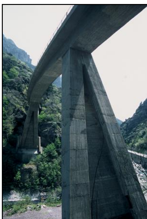
Ci-dessus et ci-dessous, détail des béquilles de soutien et du tablier béton
