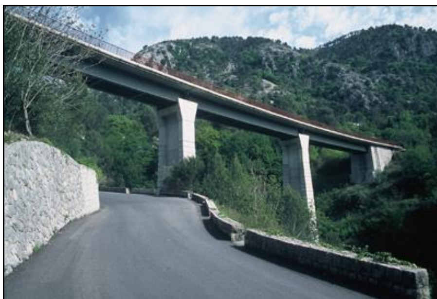
Ci-dessus et ci-après, le nouvel ouvrage à tablier mixte sur piles béton
