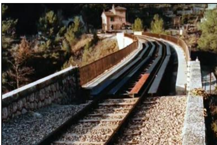
Ci-dessus et ci-dessous, trois vues des renforts qui ont dû être posés pour soutenir et stabiliser le tablier
