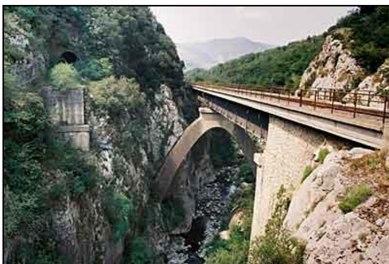
Le nouveau viaduc de la Bévéra avec, à sa gauche, la sortie du tunnel d'évitement et la première culée du pont de secours
