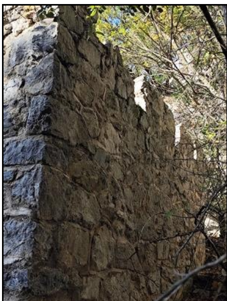
Détail du sommet d'une pile avec les décrochements des assises des travées métalliques
