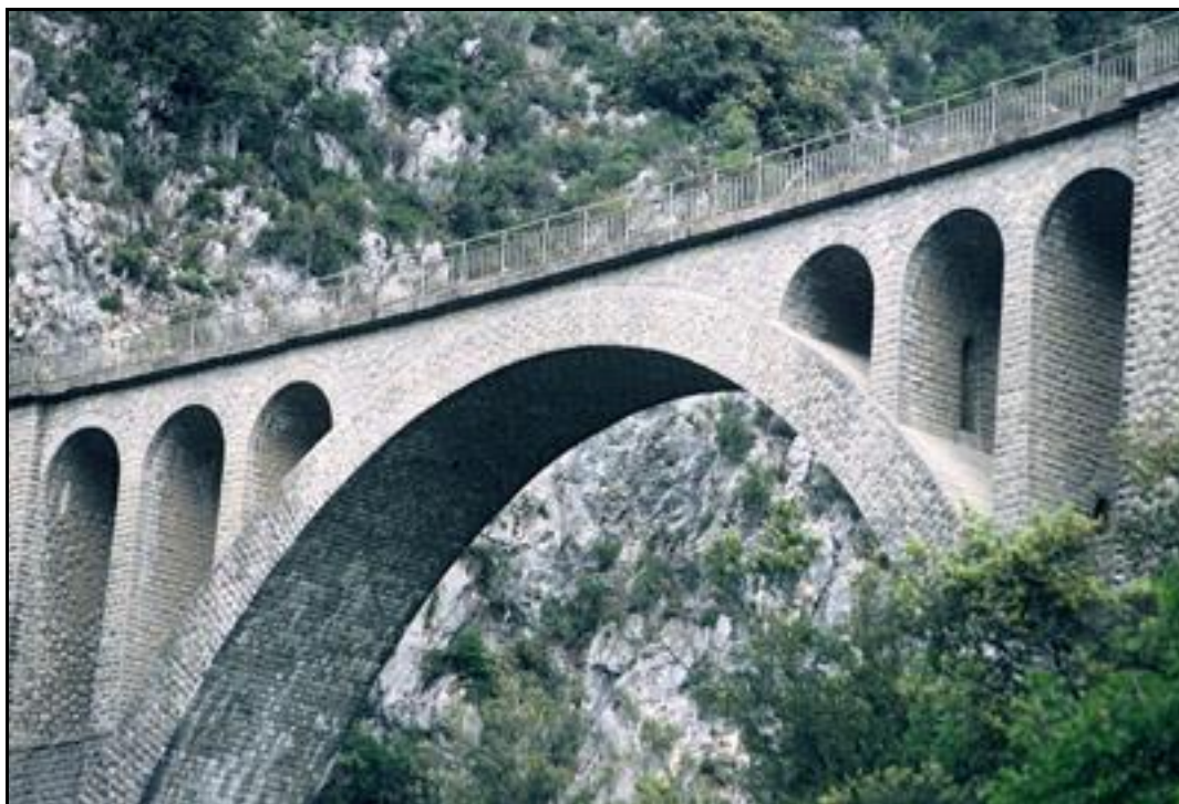
Gros plan sur l'arche et ses voûtelettes d'élégissements Noter les petits passages destinés à l'écoulement des eaux pluviales entre les élégissements
