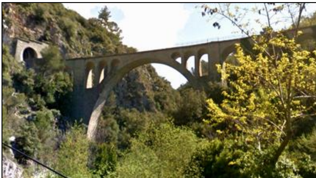
Ci-dessus et ci-dessous, gros plan sur la grande arche centrale et ses voûtelettes d'élégissement A gauche, l'arche de 10 m
