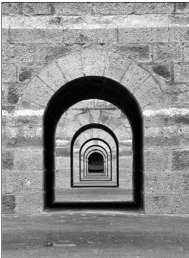
Passages dans les piles du second étage, sur le tablier du premier étage
